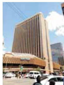
南非 Middestad Building 21层/站 4.0m/s
