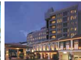
新加坡悦乐雅柏酒店 Existing Village Hotel Albert Court
